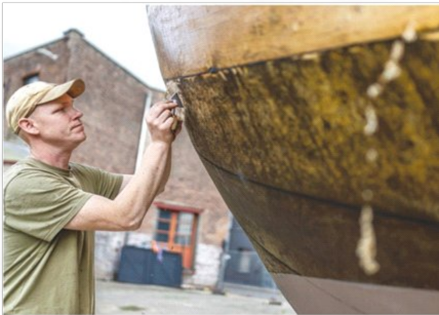
Al sinds 2010 wordt er gewerkt aan de bouw van het schip.
