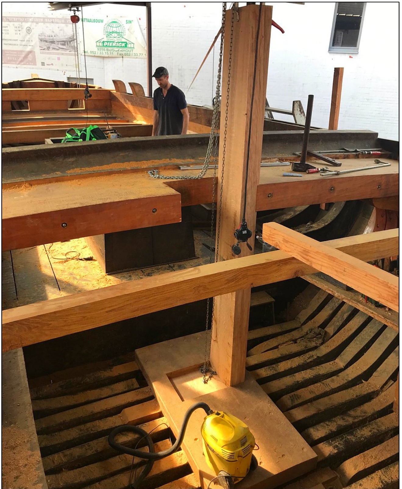
Plaatsing mastkoker in mastbank
